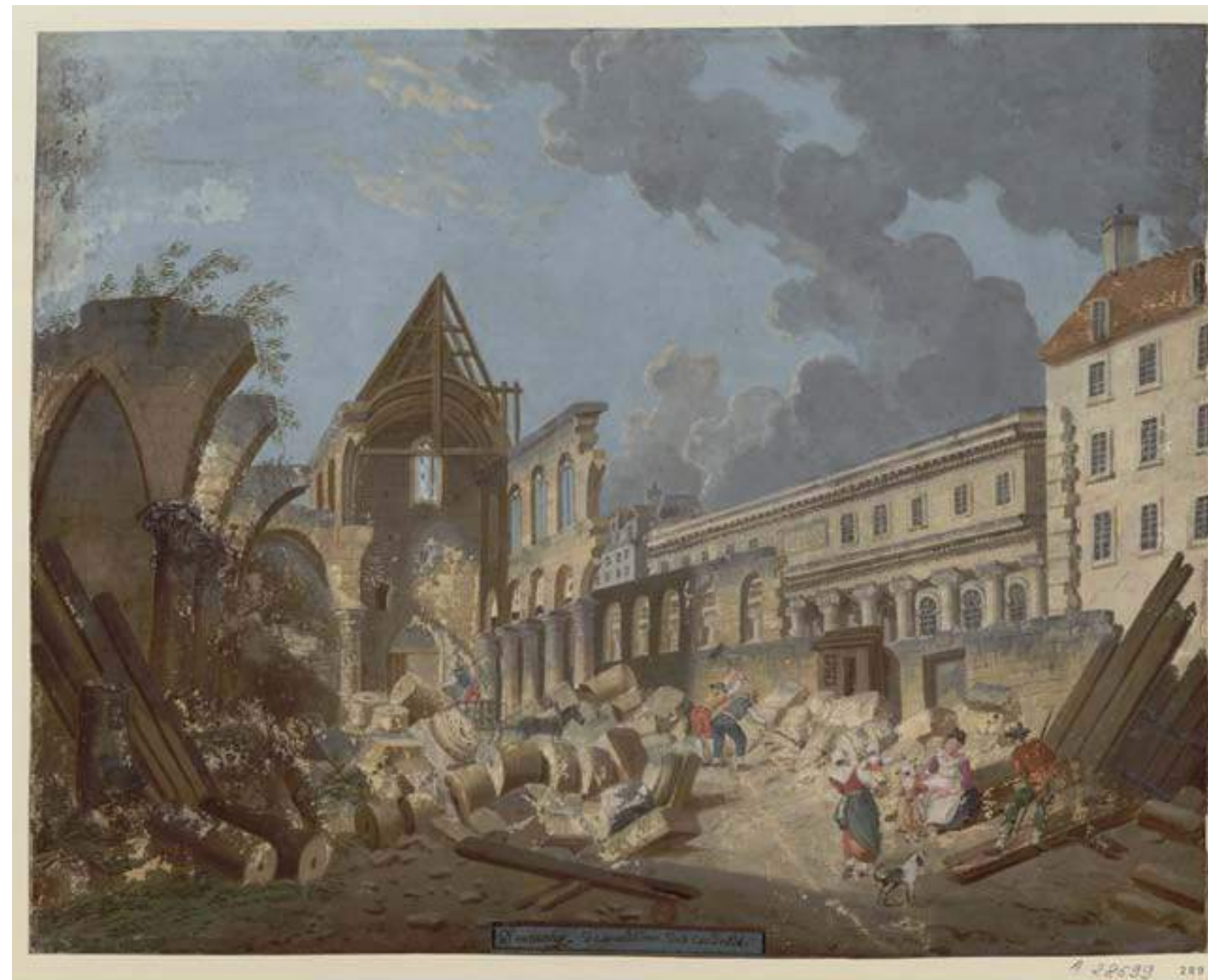
DÉMOLITION DES CORDELIERS, DESSIN DE PIERRE-ANTOINE DE MACHY, 1795.
